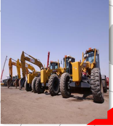
أعمال الحفر والردم
