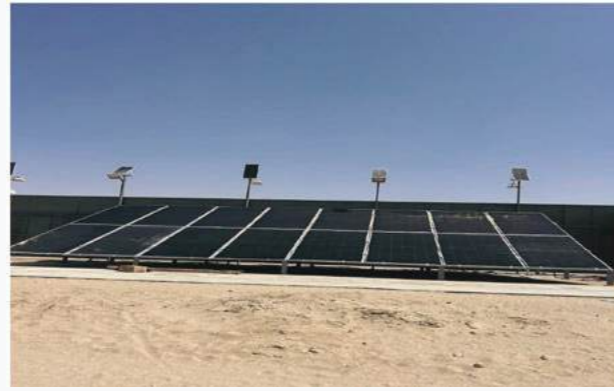
لوحات إضاءة بالطاقة الشمسية لغرف الحراسة والخدمات (مشروع بيوت المطالع)
